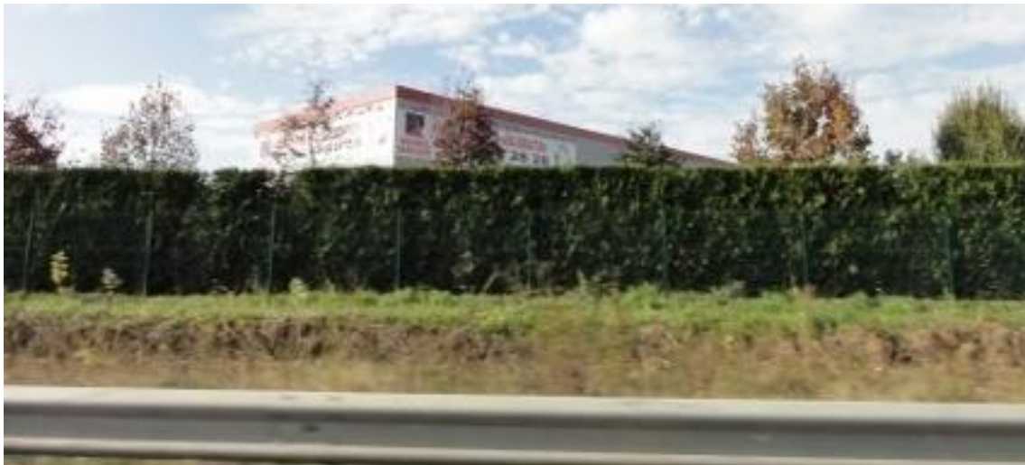
Prise de vue 4 Depuis la bretelle d'autoroute
