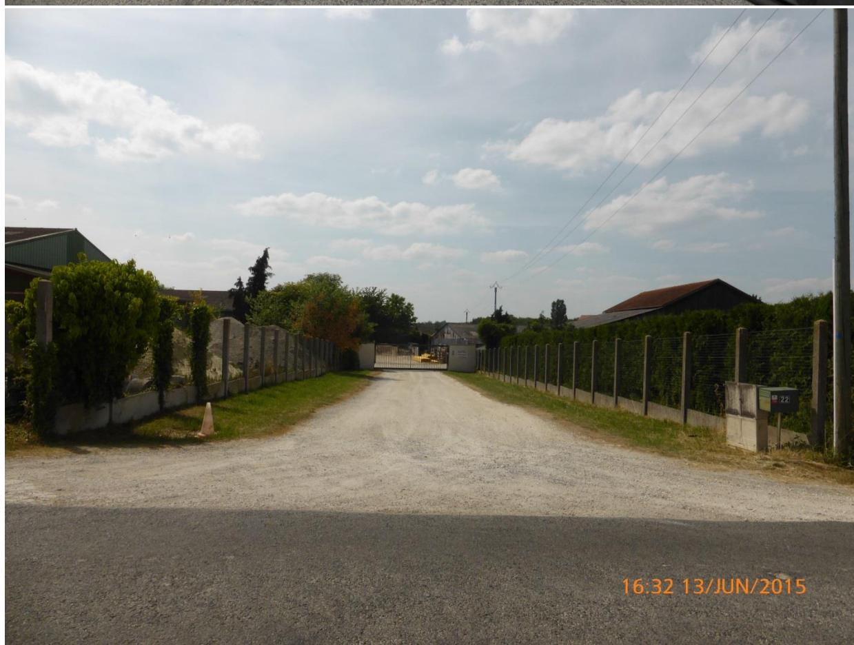
Ci-dessus, deux photos de bâtiments d'activités à l'Ouest de la RD n° 37, en face du site PROJET DRM / ICPE - / ENQUETE PUBLIQUE / Enquête n° E/15/00003677
