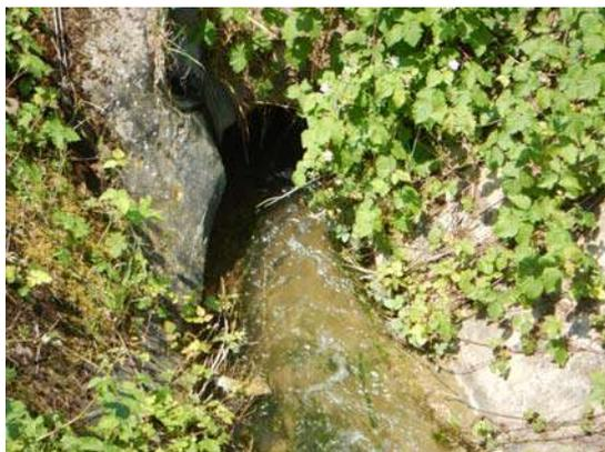
Buse de diamètre 50 cm, sensible au colmatage compte tenu de son faible diamètre.
