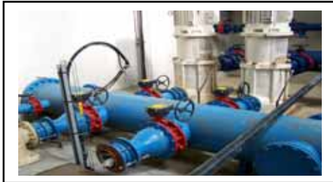
Installation de stations de traitement de l'eau potable
