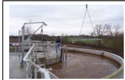
Construction et mise au norme de stations d'épuration
