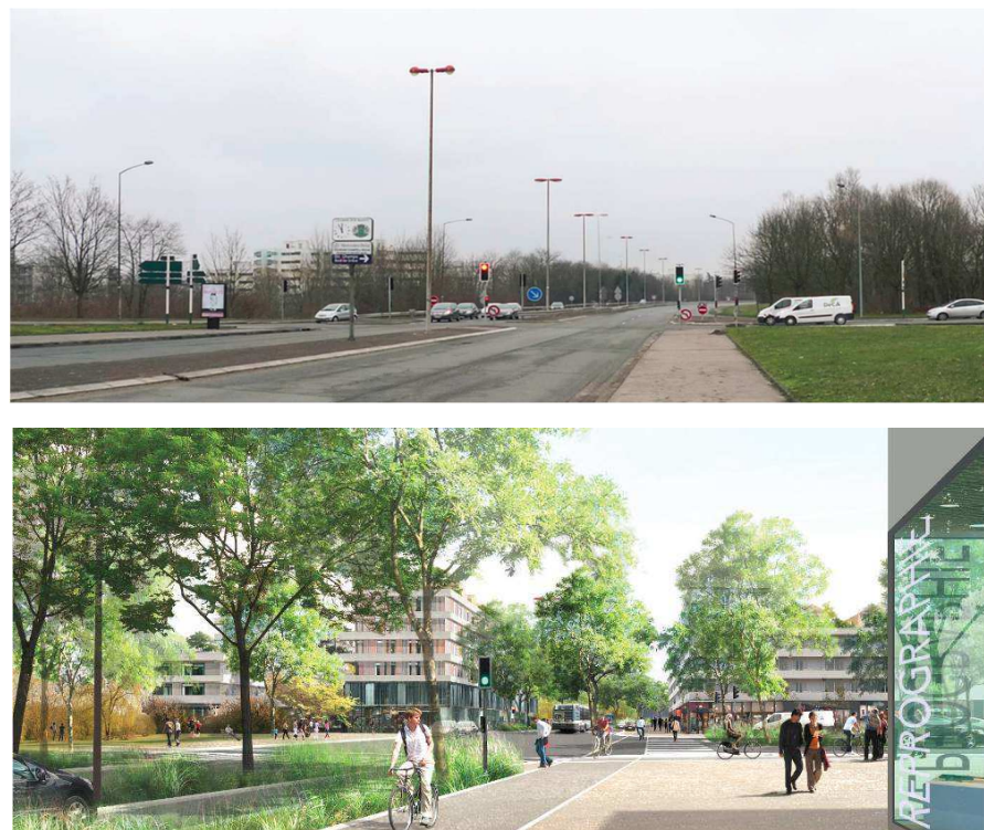
Figure 5 : Le carrefour entre le boulevard du Ru de Nesles et la RD199 - État existant (en haut) et état projeté (en bas).
