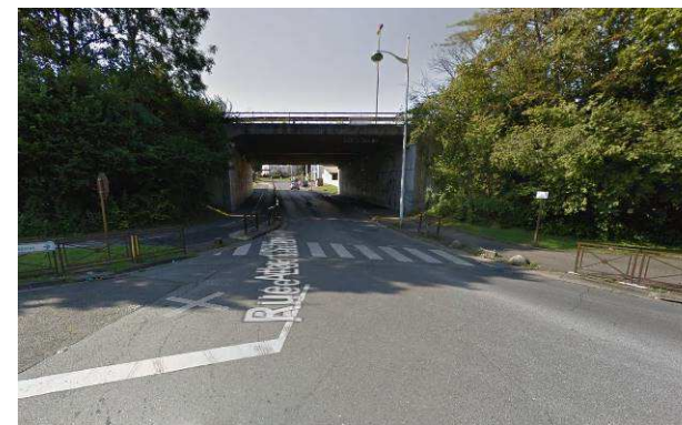
Passage sous la RD199
