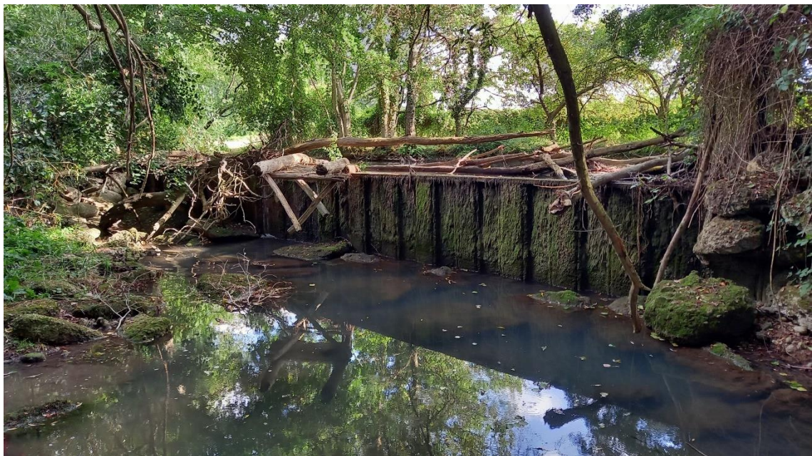
Figure 45. Vue depuis l'aval du déversoir de décharge amont OH1 du moulin Brandard
