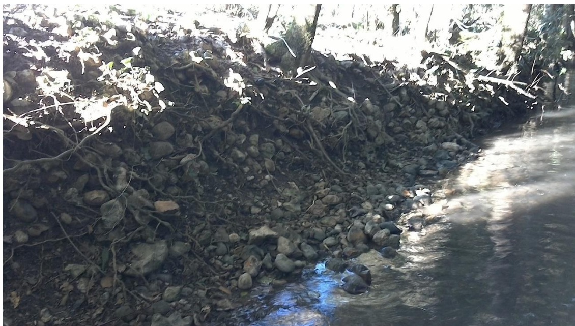
Figure 37 Exemple de profil de berge subvertical faisant apparaître des éléments pierreux en plus forte proportion dans une matrice terreuse à dominante cohésive
