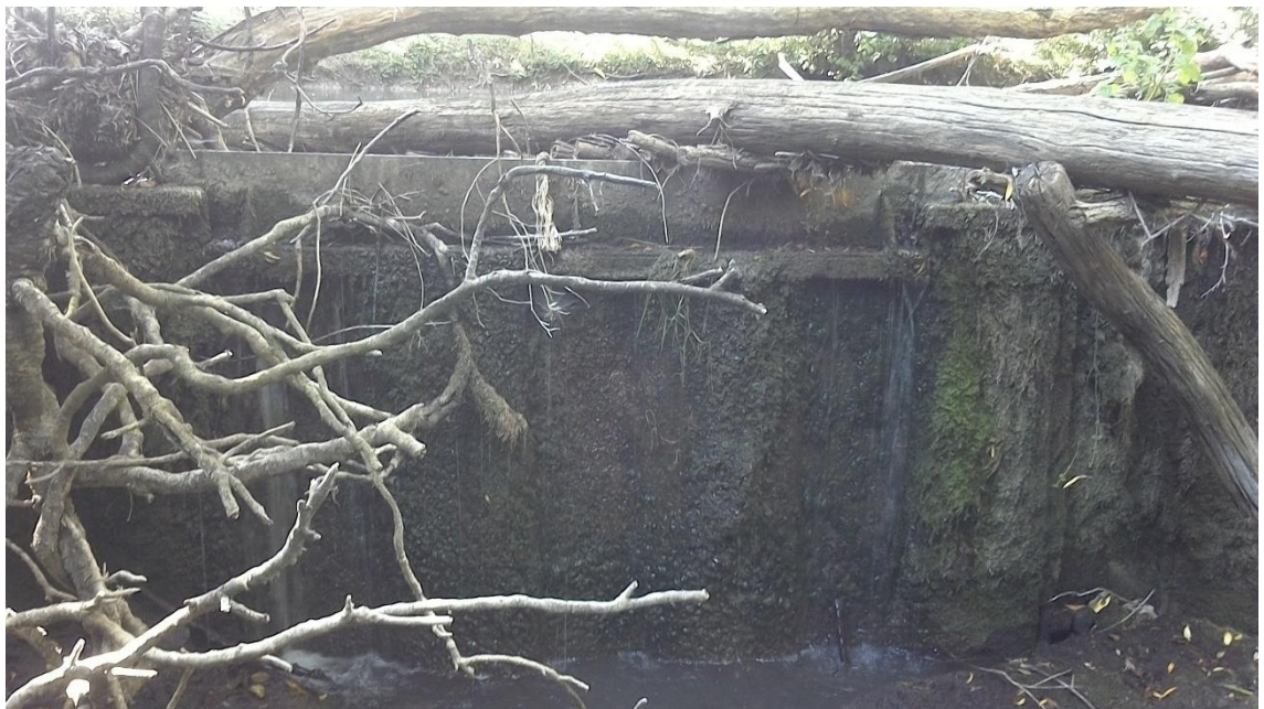
Figure 47. Vue depuis l'aval de la plaque métallique insérée dans une échancrure centrale du déversoir
