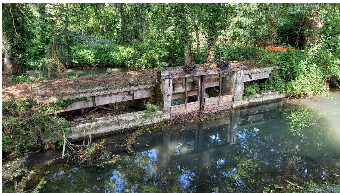
Figure 49. Vue depuis l'amont de l'ouvrage de décharge OH3 du moulin Brandard
