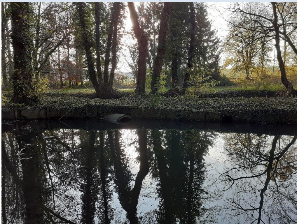
Dépose des vannes de décharge (OH3)
