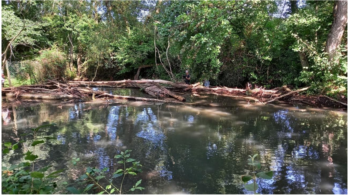
Figure 46. Vue depuis l'amont du déversoir de décharge amont OH1 du moulin Brandard
