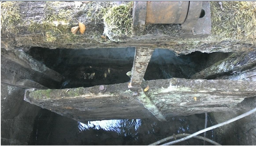
Dépose de la vanne usinière (OH3)
