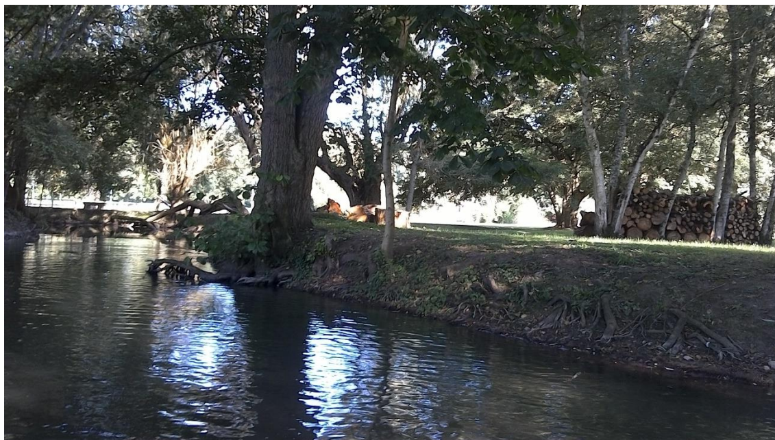
Figure 36 Exemple de profil de berge subvertical structuré par le racinaire des arbres et faisant apparaître des éléments pierreux dans une matrice terreuse à dominante cohésive
