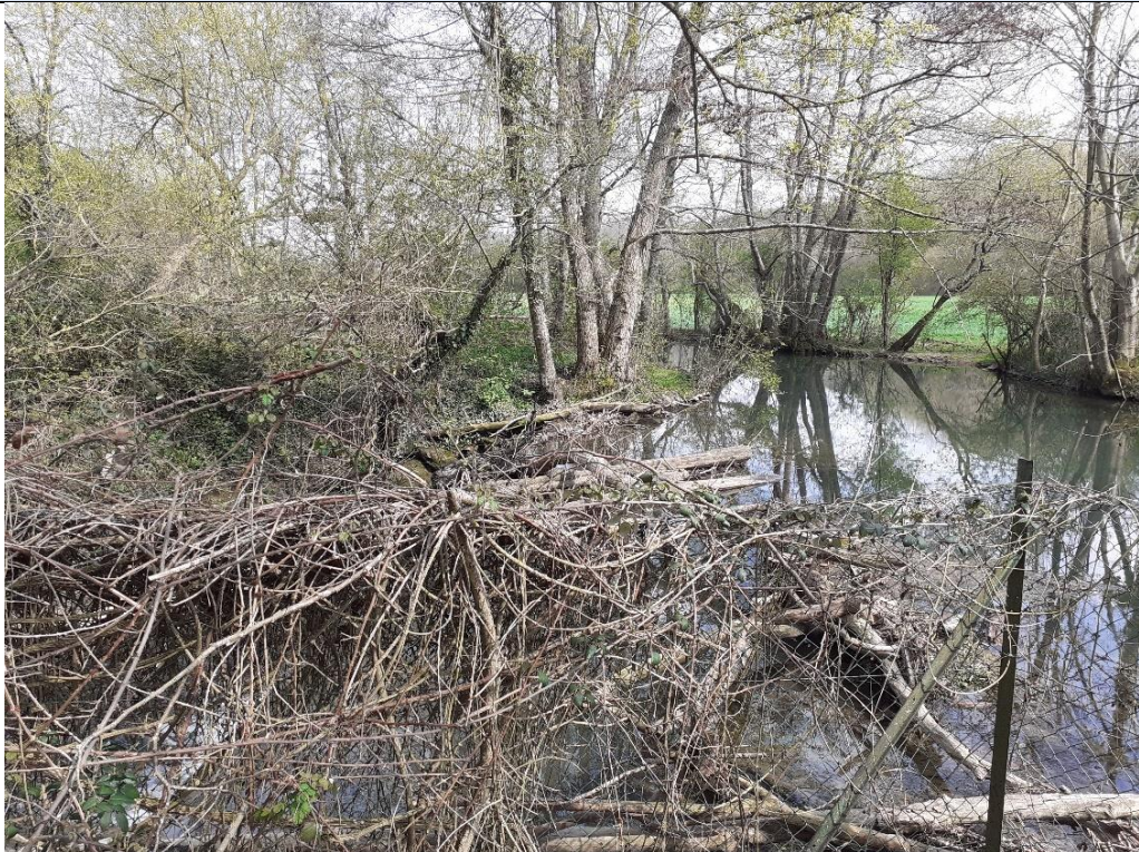
Vue des écoulements lents sur le bief et du déversoir de décharge amont encombré par les embâcles
