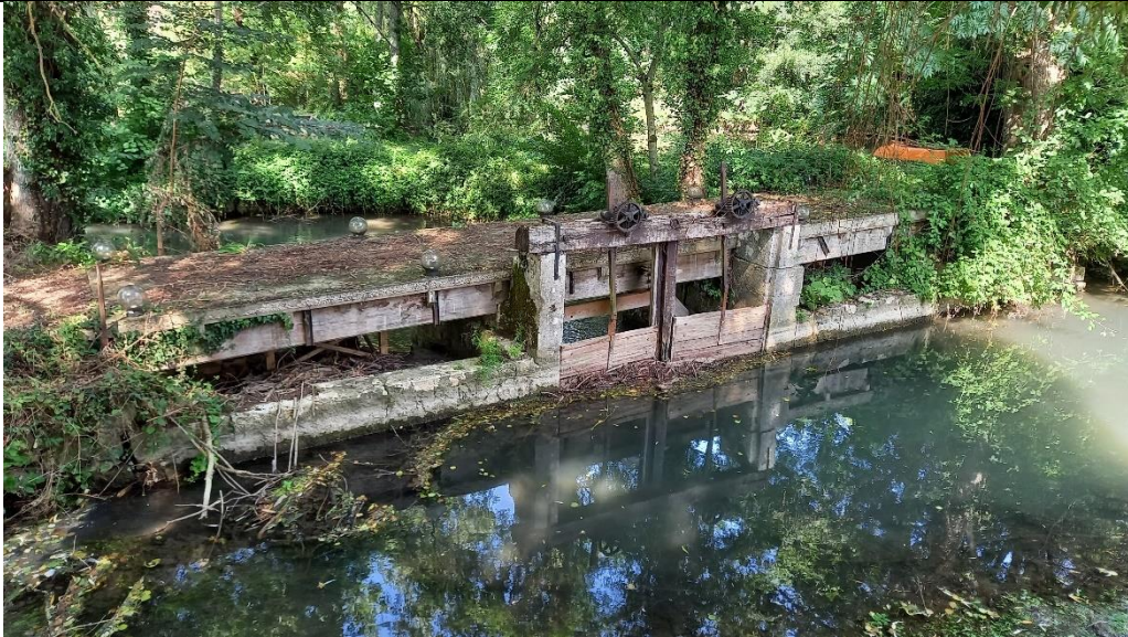
Dépose de la vanne usinière (OH3)
