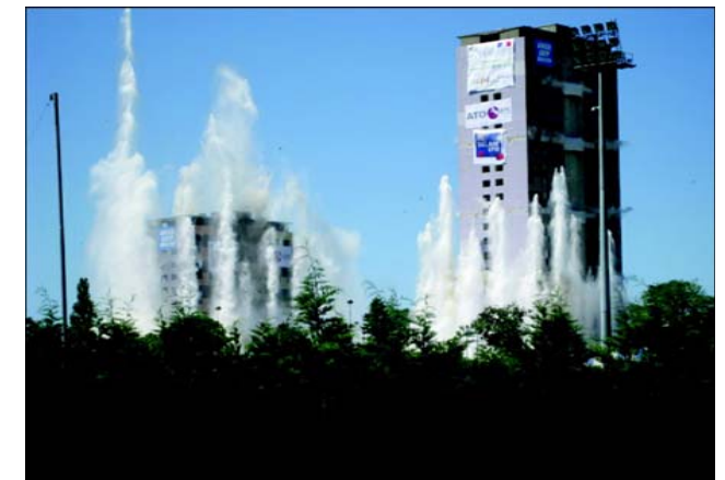
Démolition de la tour de Meau
