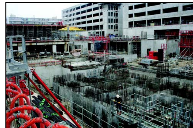
Construction du PST
