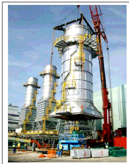
Travaux d'installation des turbines à combustion sur le site d'EDF à Vaires-sur-Marne (Source EDF)
