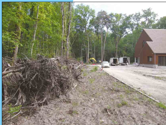
2015 - Massif forestier des Trois Pignons : Construction individuelle. Au premier plan, l'extraction des souches d'arbre implique la perte de destination forestière du sol.
