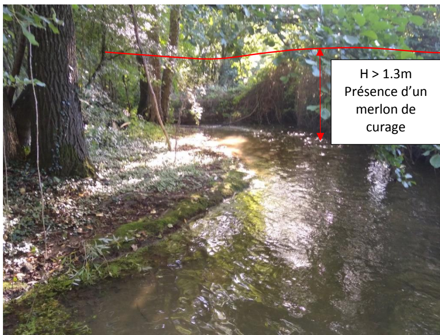
Photographie 1 : Vue sur la partie aval du tronçon T01. Présence d'un merlon de curage visible en rive gauche. (IOELE V, 2021)
