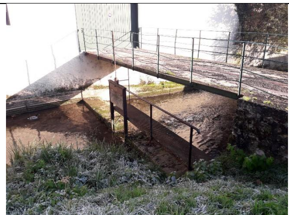
OH2 : Système de vannage et déversoir
