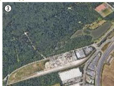
3 Extension de ZAE et délaissé en lisière de Lac et Forêts
