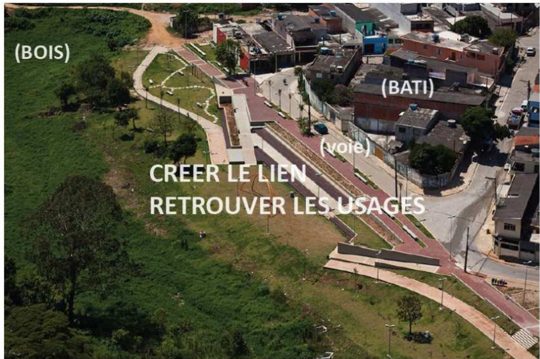
Bresil, San Paolo, Urbanisation du quartier Cantinho do Ceu, Boldarini architecture
