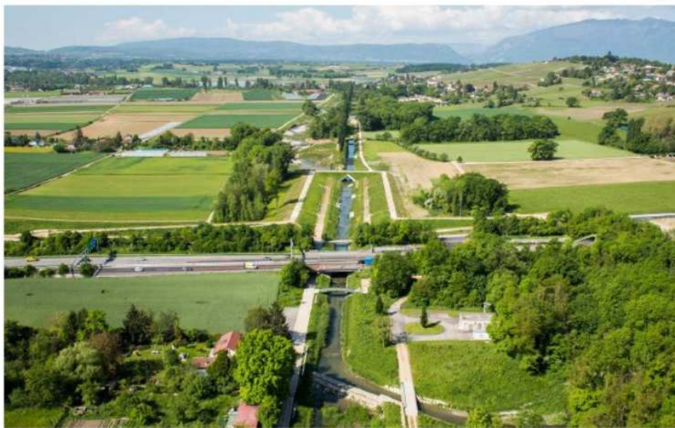
Suisse, Genève, Renaturation de la rivière Aire, Atelier Descombes Rampini
