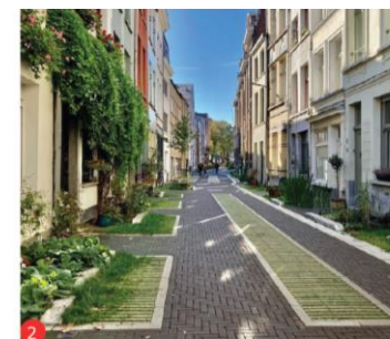
2 DESIMPERMEABILISATION D'UNE VOIRIE AVEC INFILTRATION A PROXIMITE DES BATIMENTS EXISTANTS SOURCE : URBANWATER - LANGE RIDDESSSTRAAT ANVERS, BELGIQUE
