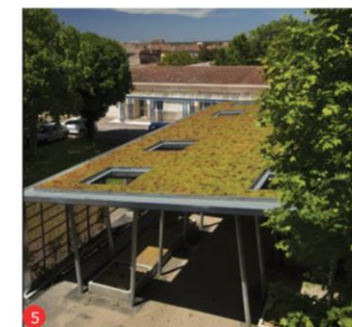
5 VEGETALISATION DES TOITURES D'UN PREAU DANS UNE COUR D'ÉCOLE SOURCE : CAUE - LYCEE JAUFFRE, BLAYE
