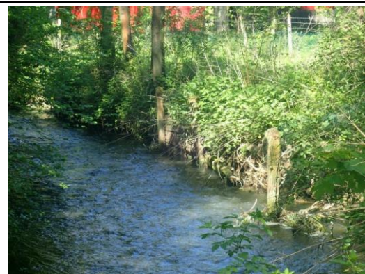
Radier sur le fossé de Montigny
