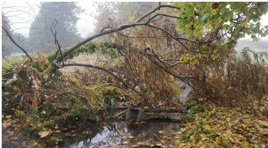
Figure 3 : Présence d'un embâcle dans un ru, CIAE, 2021
