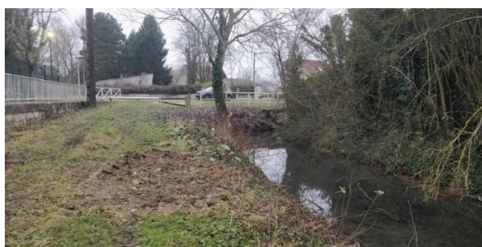
Figure 15 : Vue des massifs à traiter, CIAE, 2022
