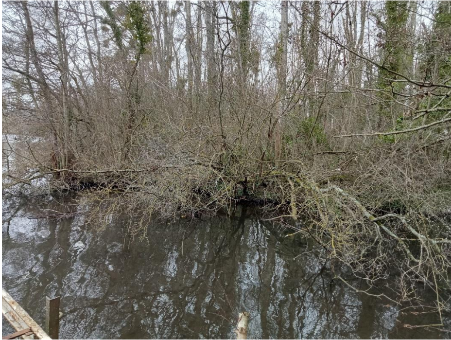
Figure 13 : Branches basses nécessitant une intervention en bateau depuis l'Yonne, CIAE, 2023
