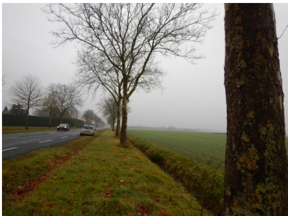
Route D607 en bordure du ru de la Mare aux Joncs
