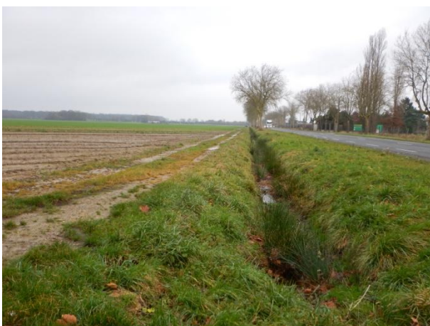
Berges dépourvues de végétation arbustive sur le ru de la Mare aux Joncs
