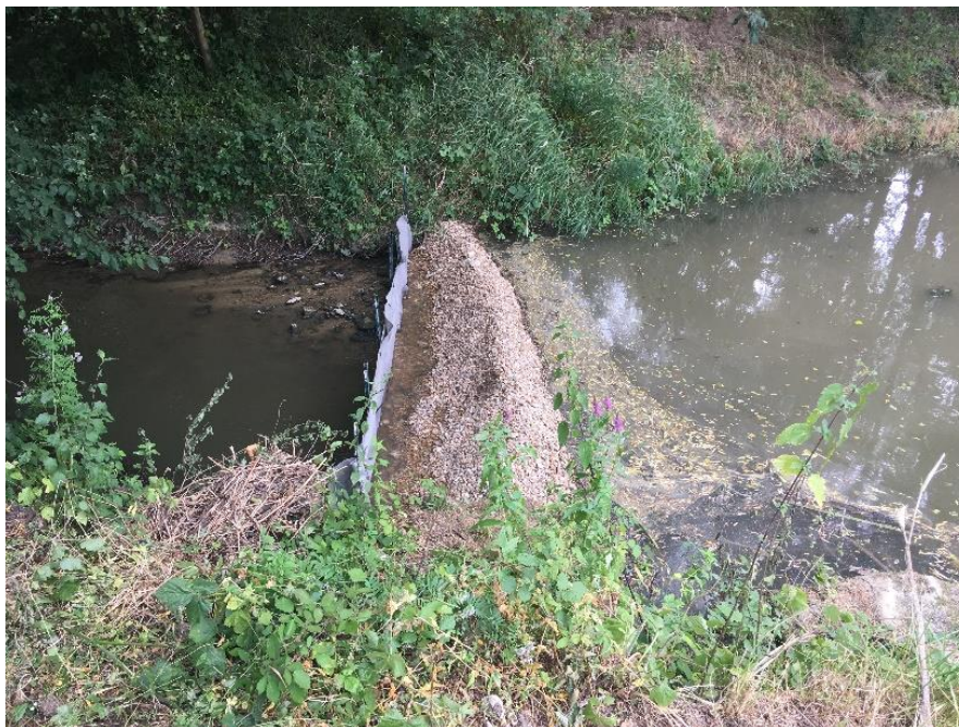
Photographie 5 : Exemple d'un barrage filtrant placé à l'aval de la zone des travaux (Saint-Maurice-sur-Fessard, 2019)
