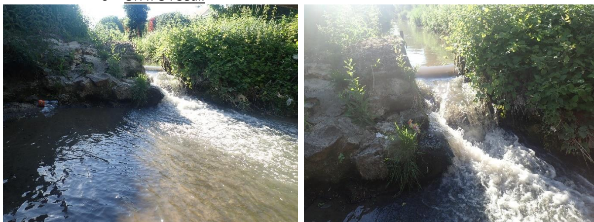
Figure 93 : Seuil en travers du lit de l'Auxence
