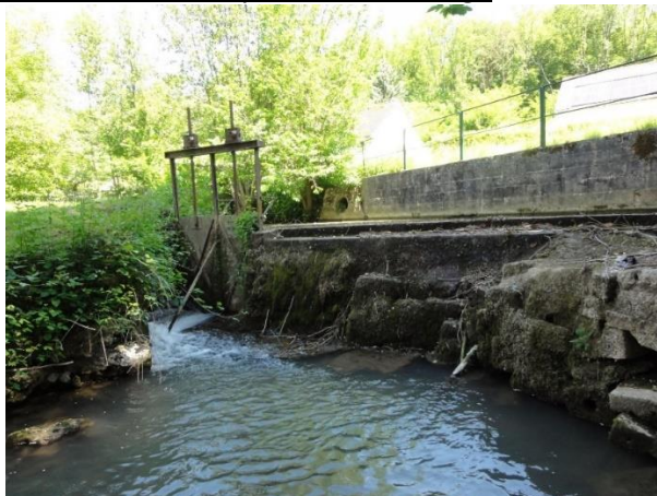
Figure 89 : Système de vannage et du déversoir
