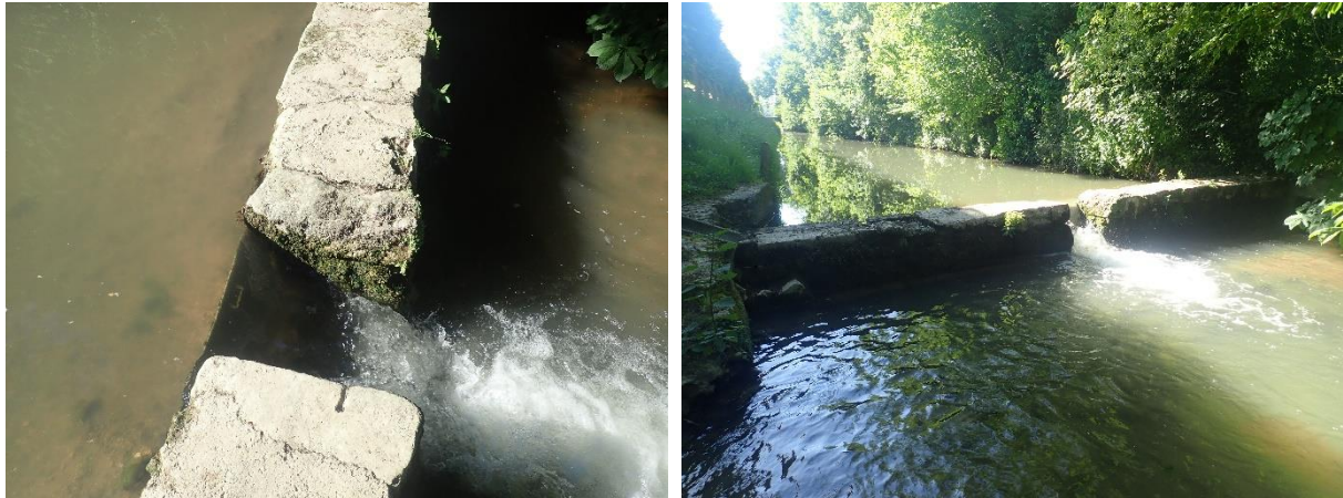
Figure 92 : Seuil en travers du lit de l'Auxence
