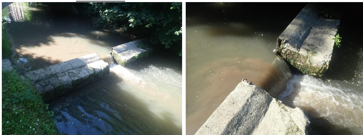
Figure 91 : Seuil en travers du lit de l'Auxence
