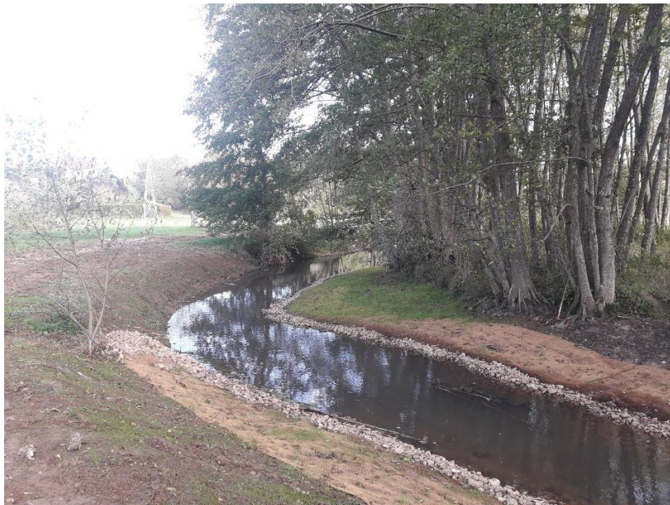
Figure 10 : Exemple de banquettes mises en place sur l'Aveyron (SEGI, 2019)
