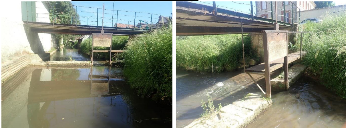
Figure 90 : Système de vannage et seuil en travers du lit de l'Auxence
