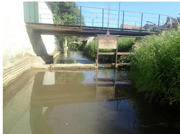
Seuil, vanne et passerelle (OH2)
