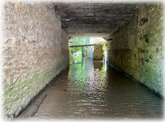
Figure 39 : Vue de l'ancien canal fuite
