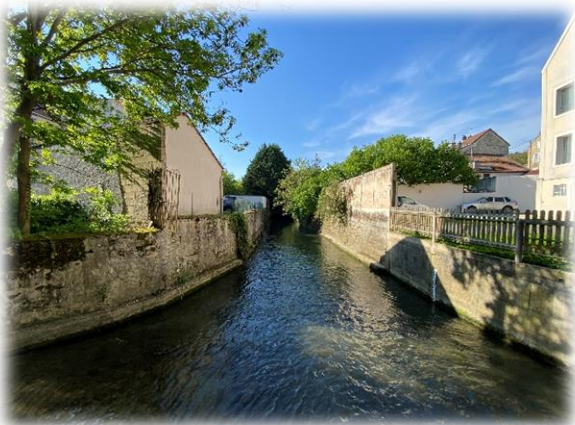
Figure 37 : Plat courant en aval du clapet
