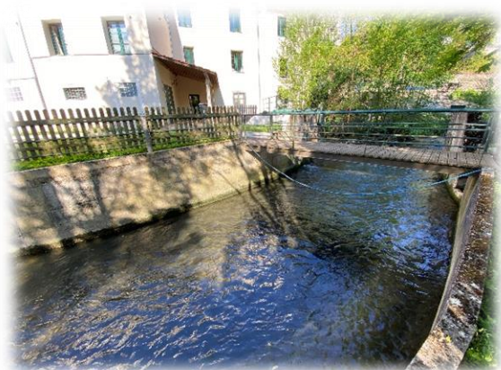
Figure 45 : Vue de la passerelle entre la rive droite et l'îlot
