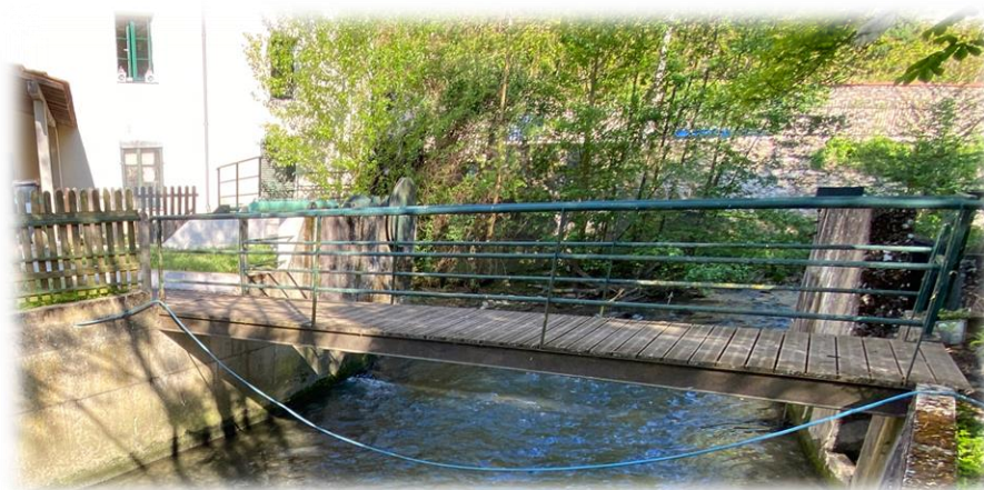
Figure 6 : Réseau électrique sur la passerelle
