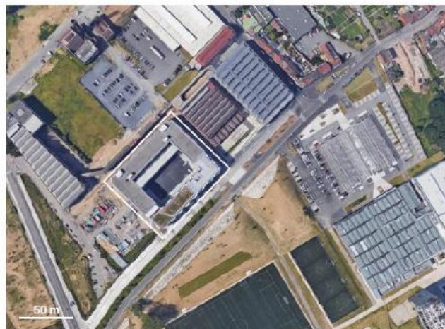
Un équipement signal dans un quartier en pleine reconversion
