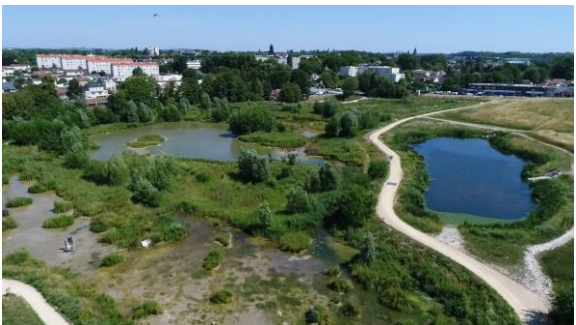
Exemple de la zone d'expansion des crues du Vignois à Gonesse (Val d'Oise)
