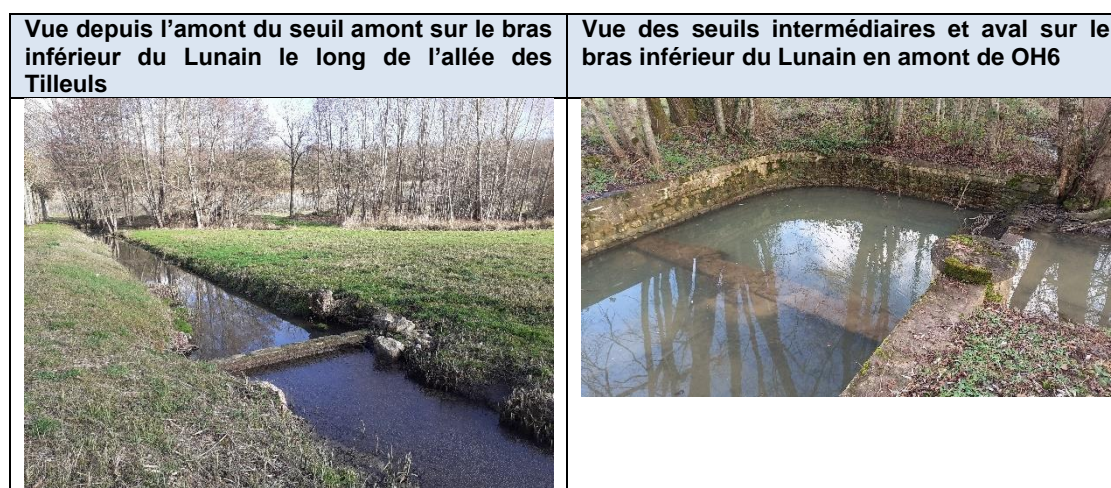
Figure 7-33. Vue des seuils sur le bras inférieur du Lunain le long de l'allée des Tilleuls
