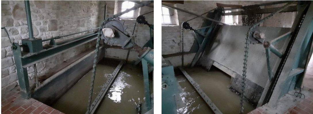
Figure 7-7. Vues de la vanne desservant le bief du moulin
