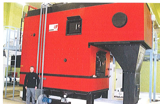
Chaudière à bois 2,5 MW
