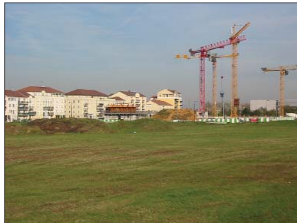
travaux sur la commune de Bussy-Saint-Georges
